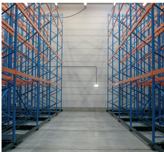
System kontroli oświetlenia
